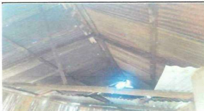
Foto 4: Viendo las vigas ya estan muy deterioradas es su tiempo de sustitucion de las laminas por troqueladas.
