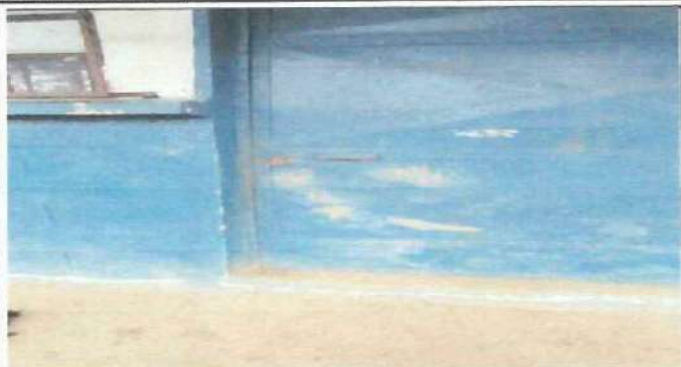
Foto1: mantenimiento de la estructura apliación de pintura del mismo color
