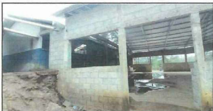
Foto 5: Repellar la pared del exterior, con monocapa pegazo.
