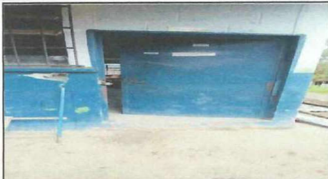
Foto 2: Mantenimiento de la puerta y sustitucion de chapa.
