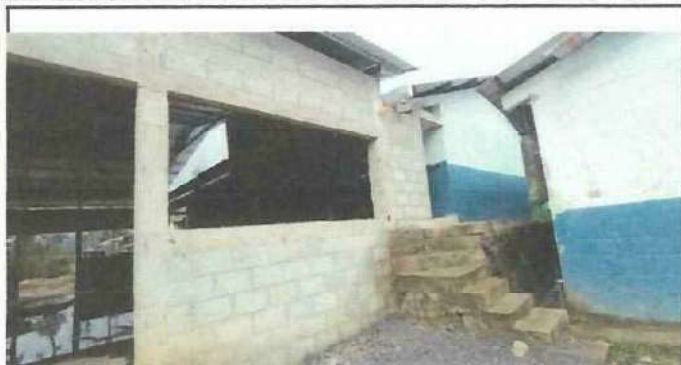
Foto1: vista exterior del salon de clase. Repellar las gradas pequeñas con cernido con plancha Rustico.
