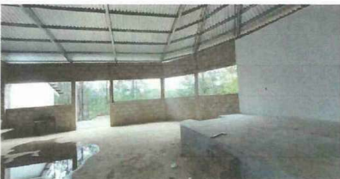
Foto 6: La vista del salon estudiantil rehabilitacion de 9 ventenas grandes con vidrios.
