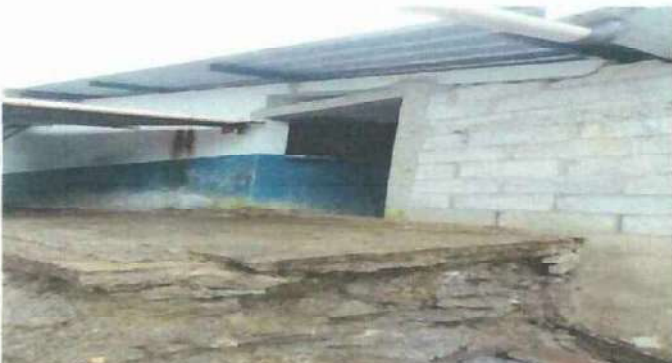
Foto 4: Observa que la necesidad de colocar una puerta pequeña de 1x0.80 m
