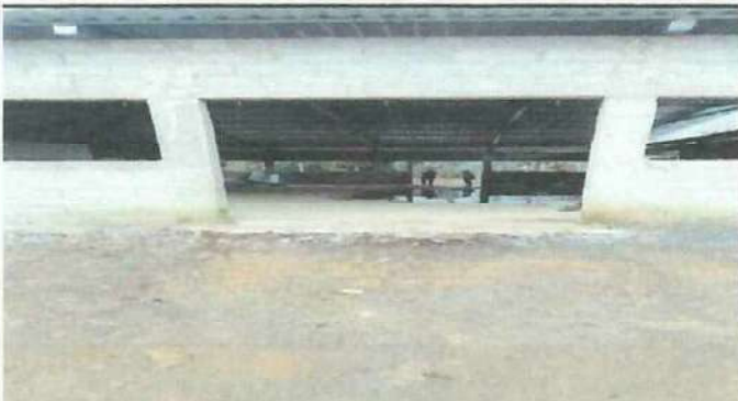
Foto 2: Observa que la necesidad de instalar una puerta grade del salon de clase. Puerta 1
